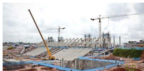
Andamento atual das obras no Itaquerao
