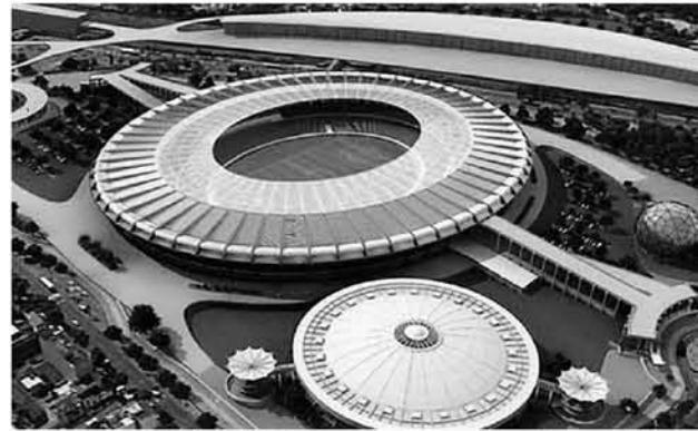
Reconstrução do Maracanã no Rio de Janeiro
